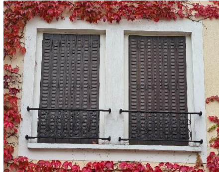
Figure 162 : Volets totalement ajourés, TP
