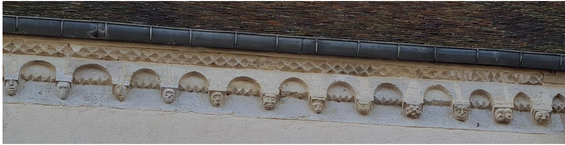
Figure 31 : Corniche d'arcatures à modillons, TP
