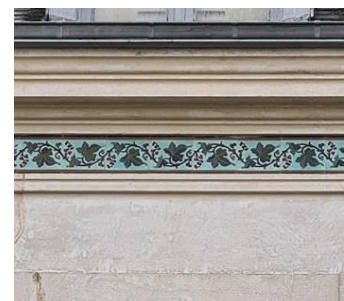
Figure 151 : Corniche et frise en céramique, TP
