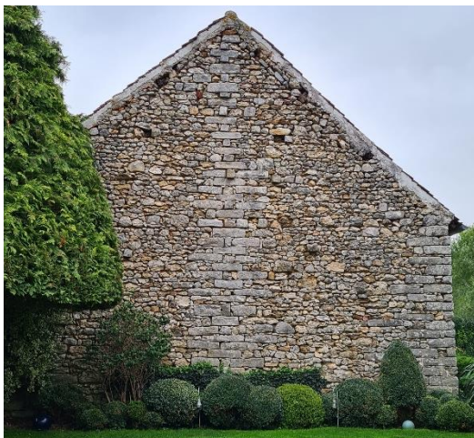
Figure 146 : Renforts en grès sur un mur pignon, TP
