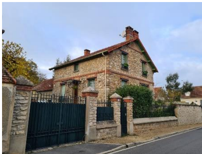
Figure 152 : Villa à modénature de briques, TP
