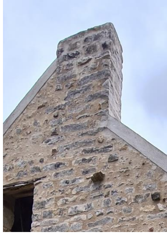
Figure 159 : Cheminée en pierre sur pignon, TP
