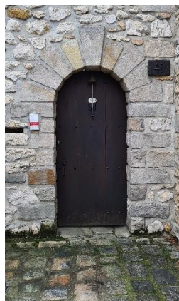
Figure 145 : Encadrement d'ouverture en grès, TP
