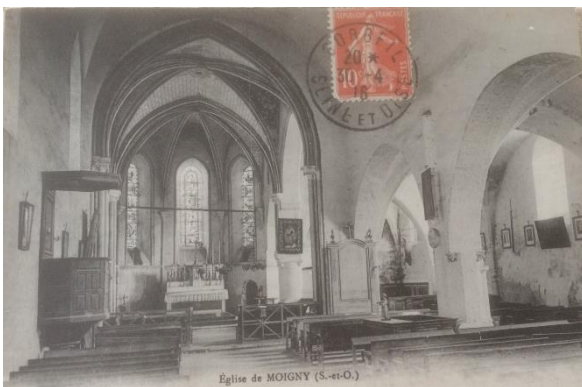
Figure 39 : Intérieur de l'église vu depuis la nef,
