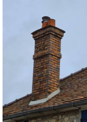
Figure 160 : Cheminée en brique sur versant de toiture, TP
