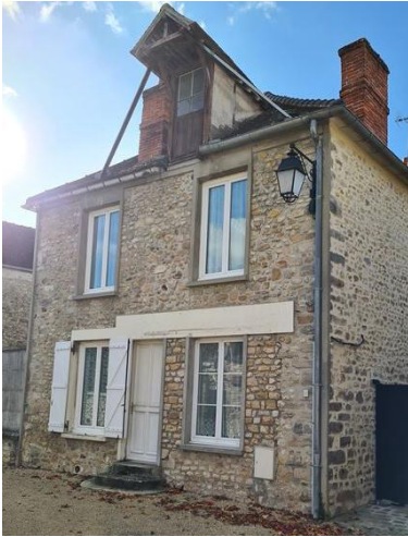
Figure 111 : Ancienne boulangerie, TP
