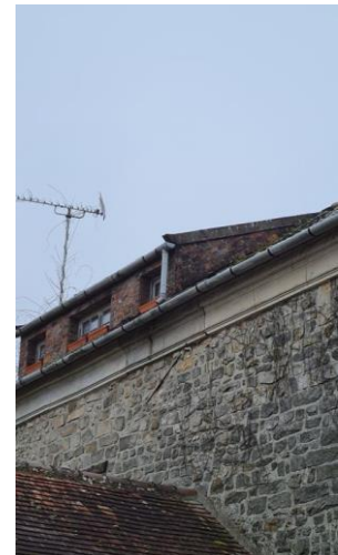
Figure 166 : Lucarne rampante, TP
