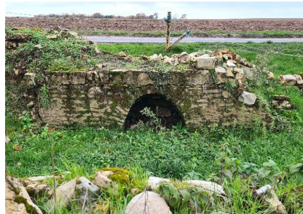
Figure 16 : Espace de stockage, TP
