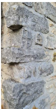
Figure 144 : Chaînage d'angle en grès, TP
