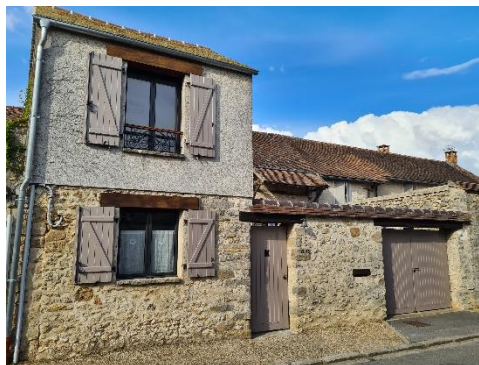
Figure 149 : Linteaux de bois, TP
