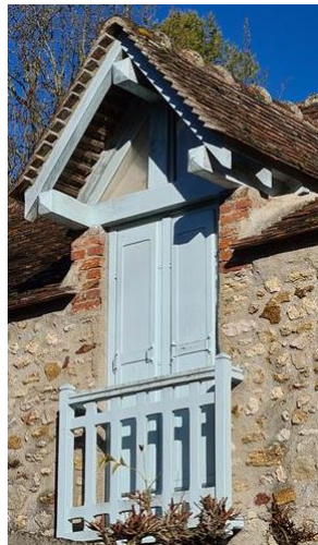
Figure 165 : Lucarne engagée dans le mur, TP
