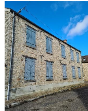
Figure 150 : Maison de bourg avec ancres et linteaux de bois, TP
