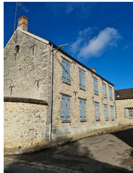
Figure 59 : L'ancienne mairie-école, TP
