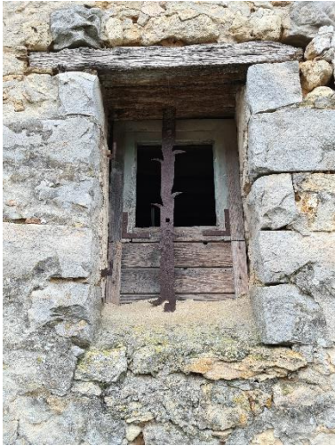
Figure 101 : Ouverture protégée, Ferme de la Maison Neuve, TP
