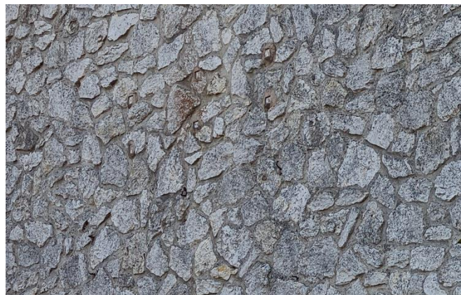
Figure 143 : Remplissage de mur en moellière, TP
