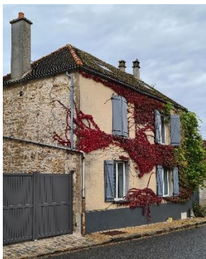
Figure 148 : Maison de bourg partiellement enduite, TP
