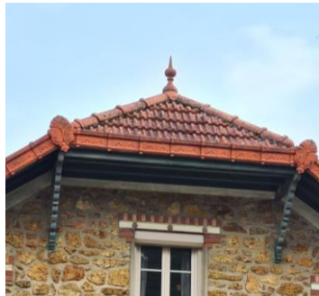
Figure 157 : Epis de faîtage et aisseliers sur une toiture en demi-croupe d'une villa, TP
