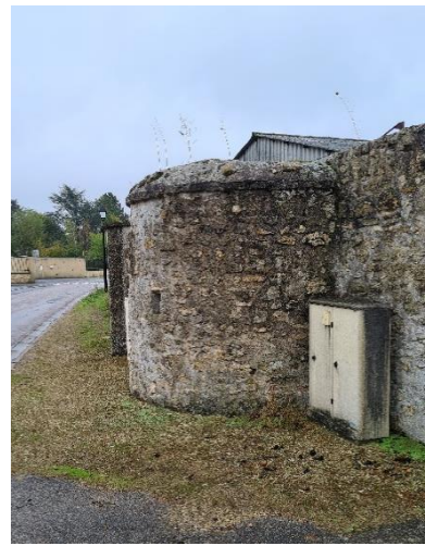
Figure 103 : Tourelle, Ferme de la Maison Neuve, TP
