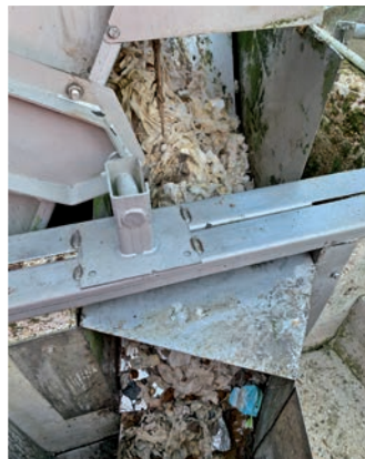
Captage de lingettes à la station d'épuration
