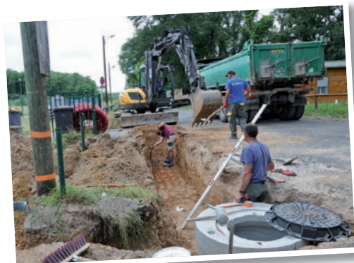
Début des travaux et préparation des évacuations d'eau
