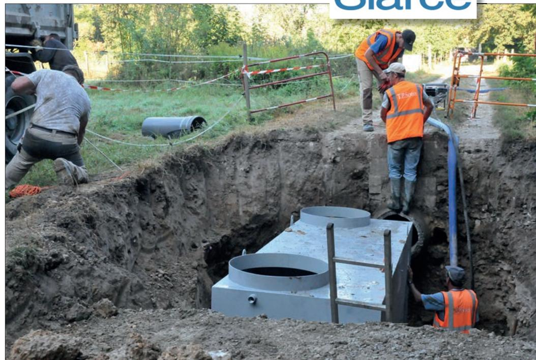
durant l'été dernier un « débourbeur-séparateur » d'hydrocarbures, chemin du Putard, sur la canalisation de collecte des eaux pluviales qui se jette dans la rivière École.
