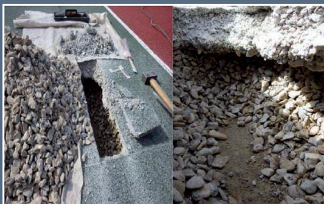
Vue sur sondage : coupe sur structure, géotextile en fond. Une microfissuration est présente sur la surface bosselée, sur une surface supérieure à 1m<sup>2</sup>. Elle est associée à la présence de dépôts minéraux à l'aplomb des fissures (probable migration d'éléments issus du ciment)
