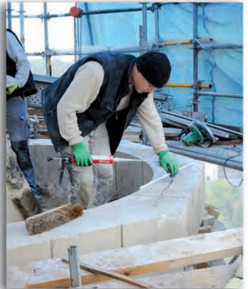
Pose de broches en fibres de verre
