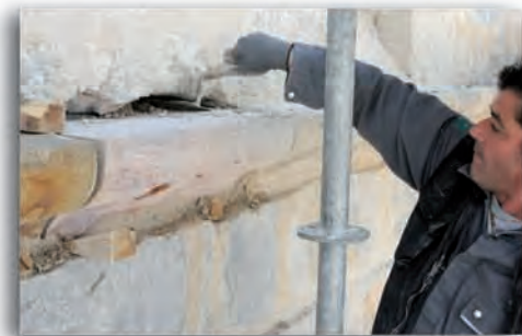
Scellement de pierres de corniches
