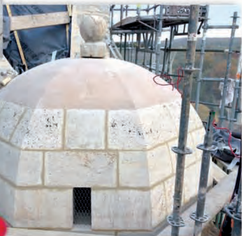
Pose de broches en fibres de verre
