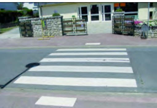
Allongement des bandes podotactiles
