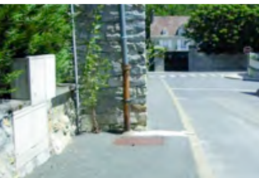
Abaissement du trottoir pour les PMR
