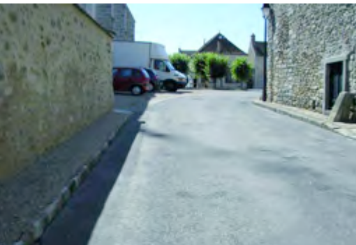
Obstacle sur trottoir
