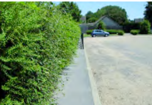
Élargissement du trottoir du parking des écoles
