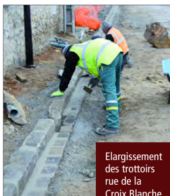
Remplacement de la distribution d'eau rue de la Croix Blanche
