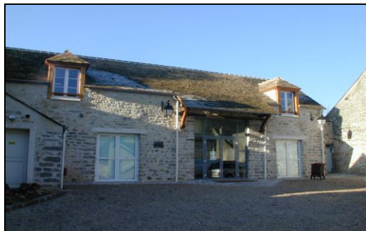
Médiathèque municipale La Grange
