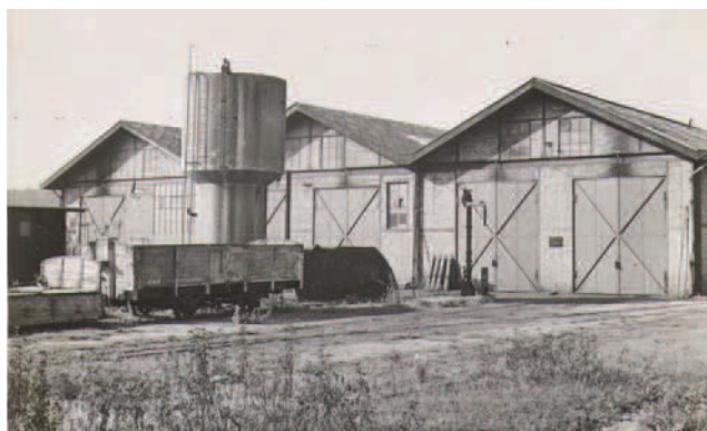
Le dépôt C.G.B. du Bas-Coudray à Corbeil (1951) [AD91 : 5S/172]
