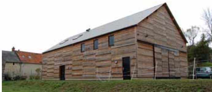
Chamarande, rythme créé en façade dû au relief apporté par l'assemblage des lattes
